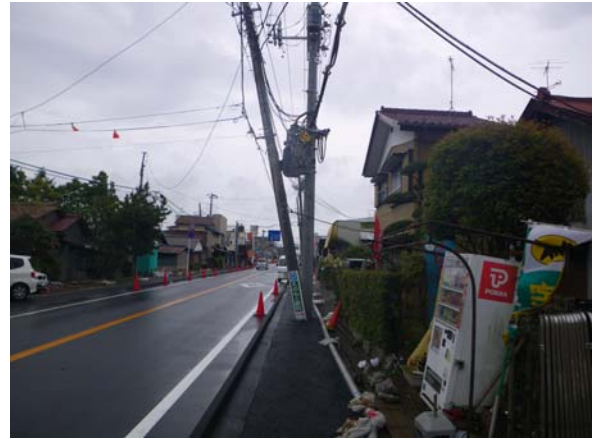
写真3. 調査対象地点の液状化状況
