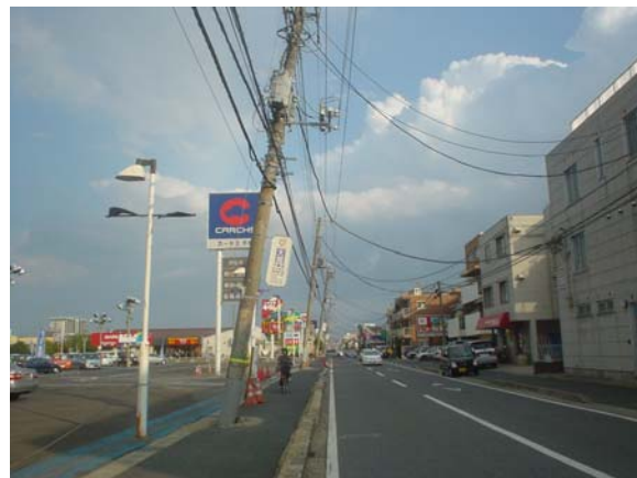
写真2. 傾き歩道に埋没した電柱
